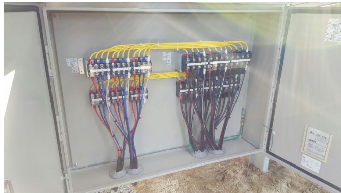
写真1－導体サイズ変換箱 (5.5 mm 2 →38 mm 2 )
